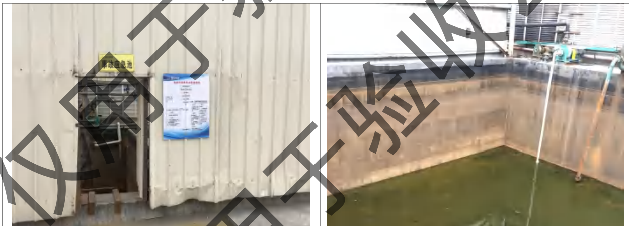
特钢公司已建的 480m 3 事故应急池
